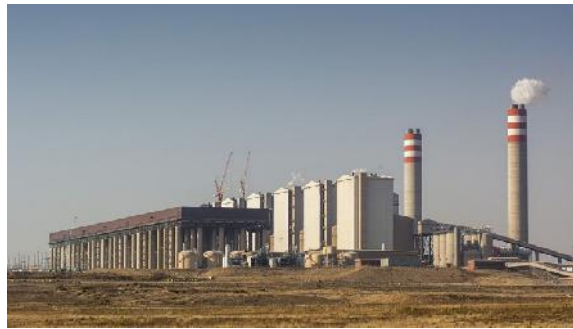
Kraftwerk Kusile (eskom)
