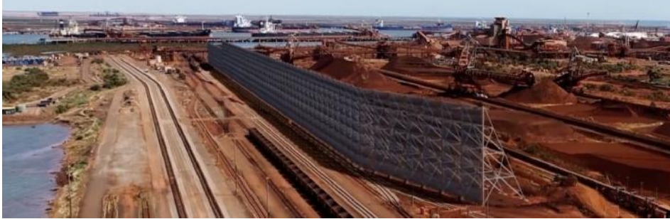
Windzaun auf dem Hafengelände Hedland (bhp)
