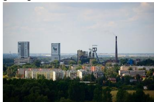
KWK Bielszowice (eksploratory)
