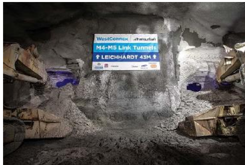
Durchschlag der beiden TSM (westconnex)
