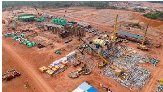
Bau Aufbereitung 1 (Ivanhoe)
