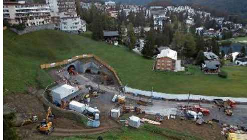
Baustelle Tunnel Arosa (Aargauer Zeitung)
