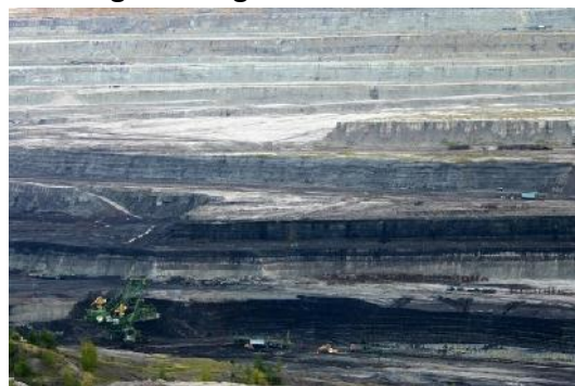
Tagebau Turów (NetTG)
