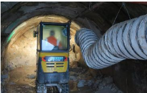
Durchbaurbeiten im Schrägschacht
