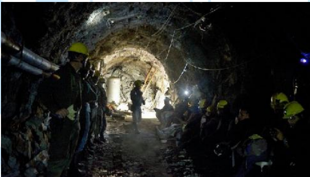
Streckenauffahrung im Goldbergwerk La Mina
