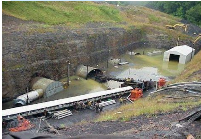
Bergwerk Quecreek nach der Überflutung am 24.07.2002
