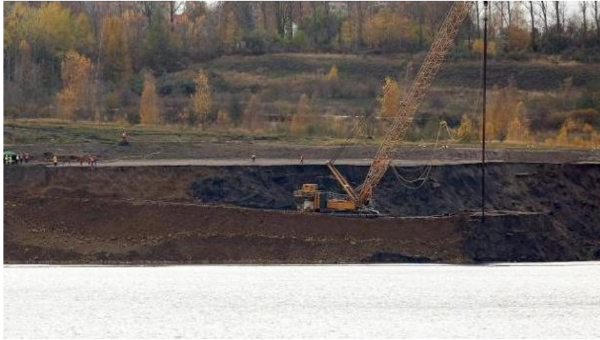
Seilbagger an Concordiassee
