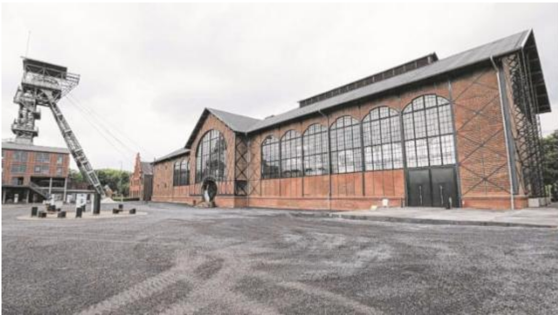
Die Außenfassade kommt dem Originalzustand jetzt sehr nahe. Deutlich zu erkennen: das dunkle Stahlfachwerk
