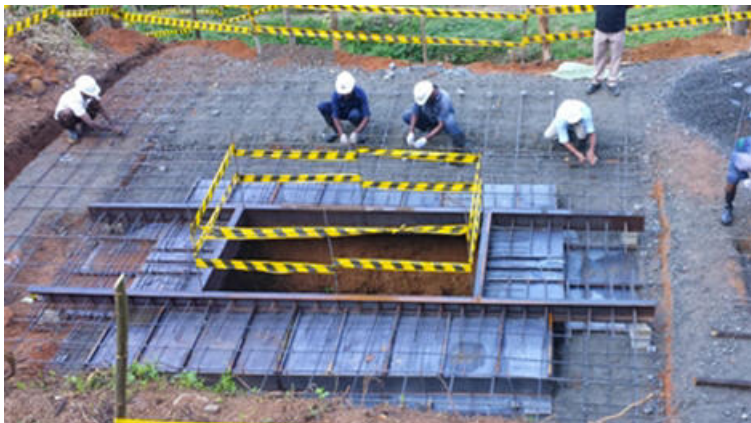
Erstellen des Schachtkopfes
