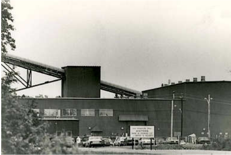
Tagebau East Kempville
