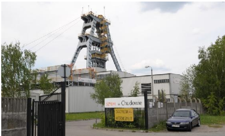
Schacht VI KWK Budryk
