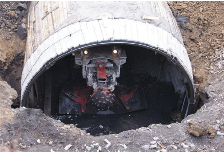
Bau des Schrägschachtes
