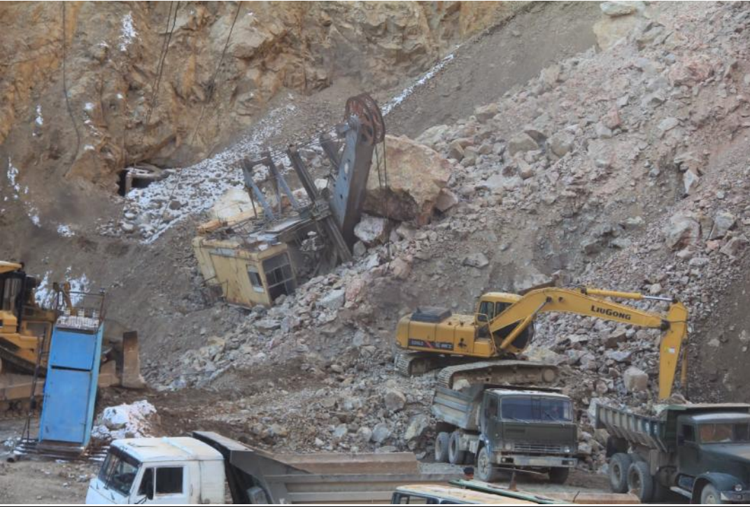
Böschungsrutsch Goldtagebau Aprelevka in Tadschikistan
