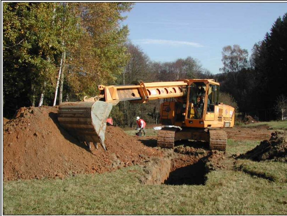
Abb. 9 : Schurfarbeiten mit schwerem Gerät bei der Explorationskampagne der DEUTSCHEN ROHSTOFF AG 2008
