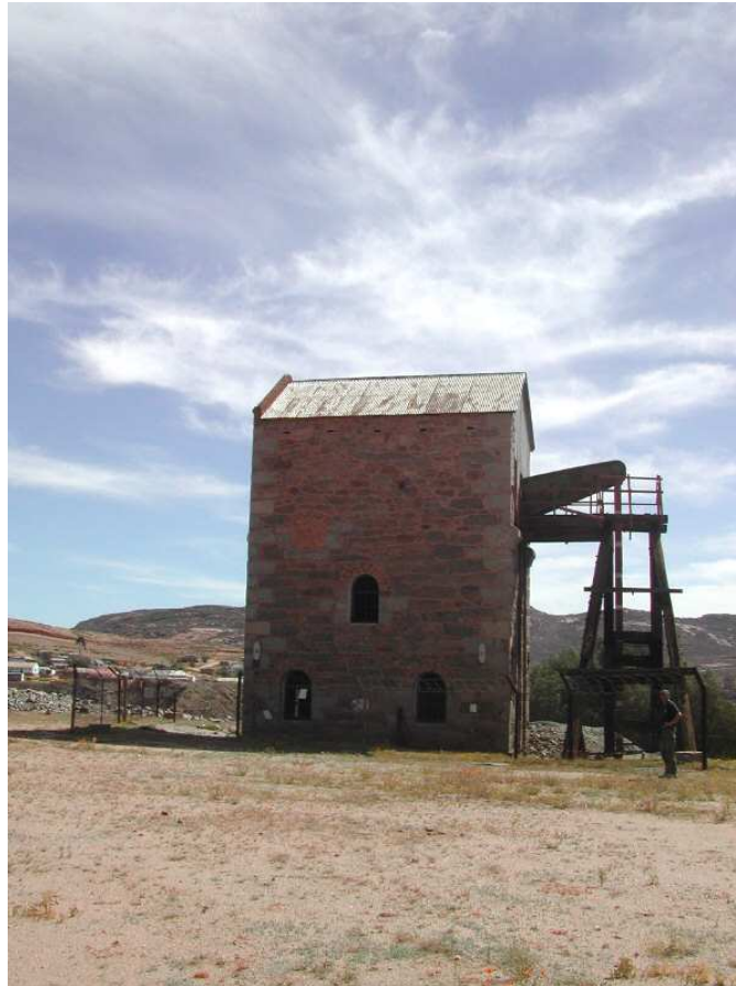
Abb. 7 : Gut erhaltenes Cornish Engine House von 1882 in O'okiep, Namaqualand, RSA Laut Plakette der einzige original erhaltene Cornish Engine auf der südlichen Halbkugel
